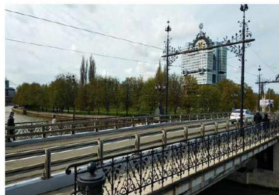
Калининград, Деревянный мост. фото автора.
